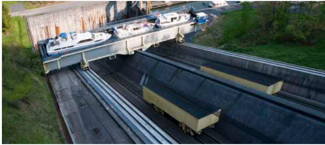
Das Schiffshebewerk in Arzwiller.
